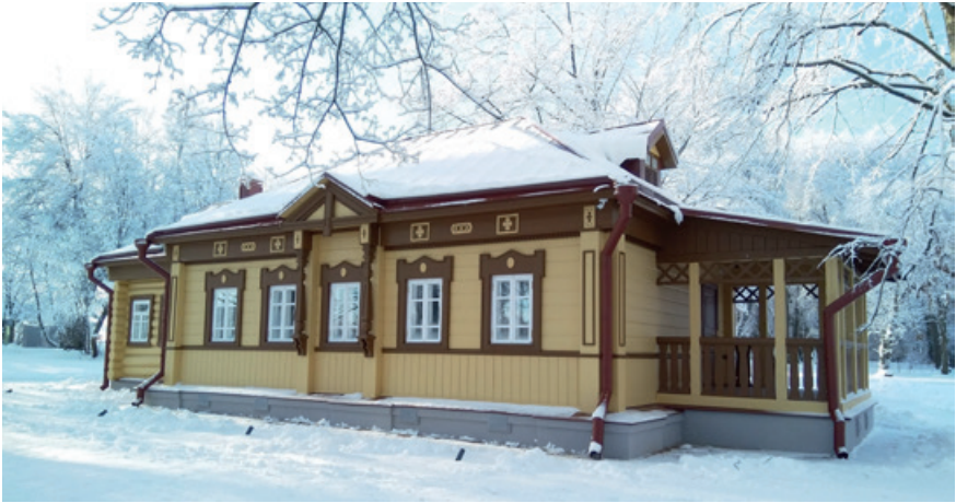
Флигель после реставрации (вид со стороны деревни). Декабрь 2021 Outbuilding after the Restoration (View from the Village). December 2021
